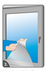
Lösen Sie den Schutzfilm von der Folie. Dies gelingt ganz gut, indem man 2 Streifen Tesafilm an einer Ecke befestigt und langsam auseinander zieht.
